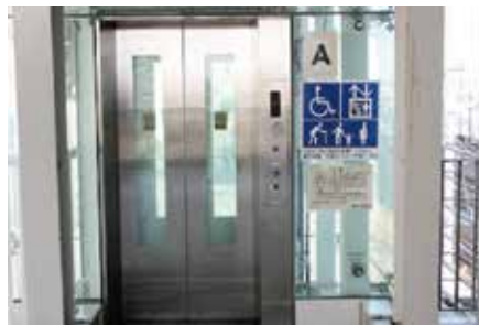
②北口すぐ右手のエレベーター (A) に乗り、1階へ降ります
